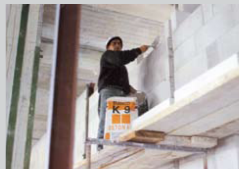
Кладка перегородок из пеноблоков
