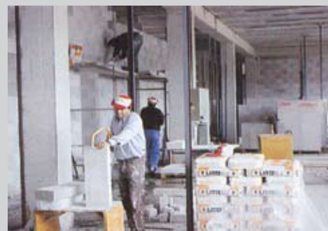
Подготовка пеноблоков
