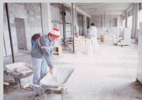
Приготовление раствора ВЕТОНКОЛ К9
